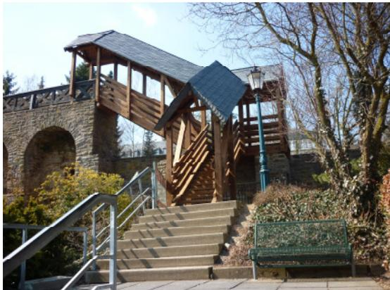
Infolge der statischen Überprüfung der Holzkonstruktionen des Wehrganges auf ihre Tragfähigkeit im vergangenen Jahr wurde unter anderem festgestellt, dass die Holz-Treppenanlage im Bereich der ehemaligen „Roten Brücke“, welche zum Aufstieg auf den Wehrgang dient, sehr marode ist und somit erneuert werden muss.
